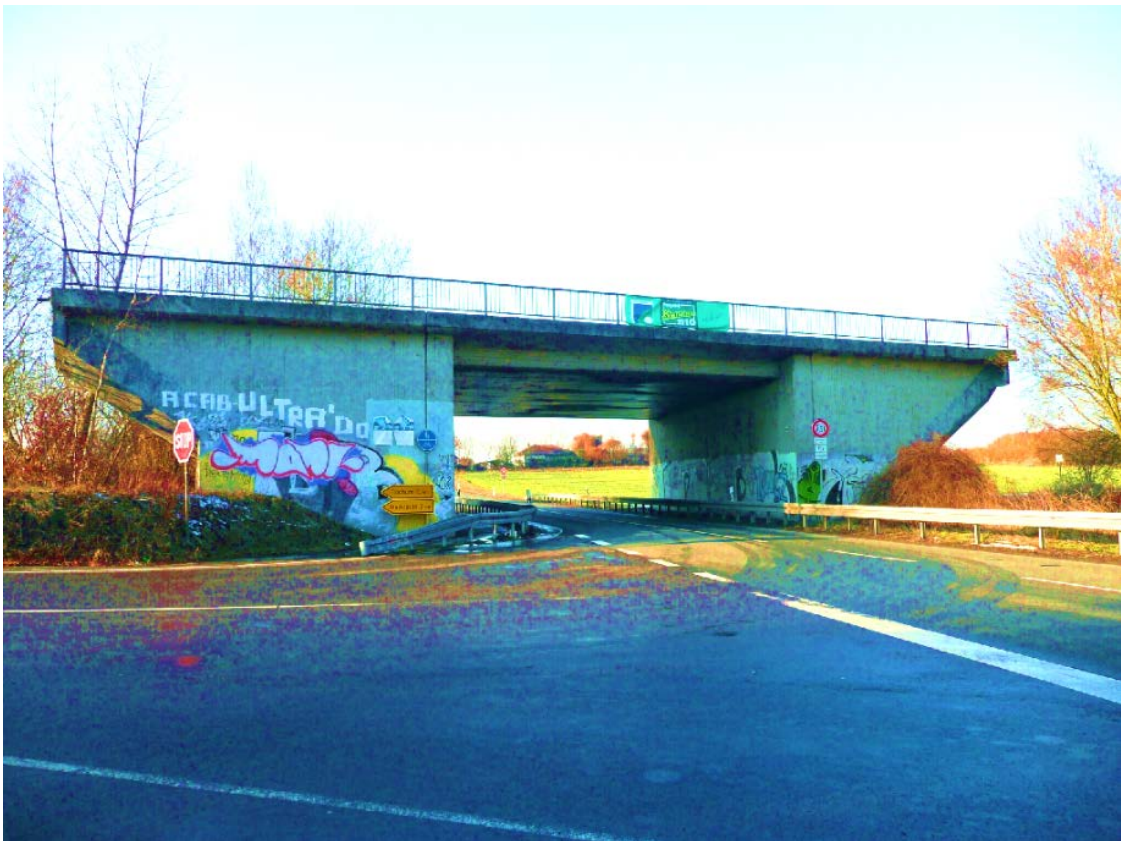
Bild: CC BY-SA 3.0: https://upload.wikimedia.org/wikipedia/commons/8/83/Soda_Frohlinde.jpg . (Farben nachbearbeitet.) Die „So-da-Brücke“ von 1978 bei Castrop-Rauxel Frohlinde.
